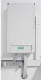
Hausanschlusskasten
