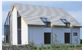
Dachseite für PV-Anlage
